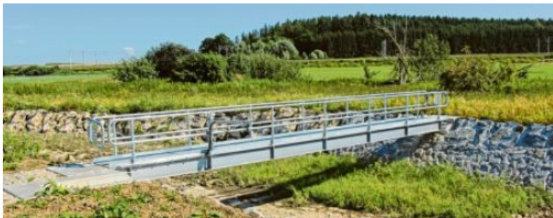
Beim Prüfsteig wird die Höhe des Wasserstandes gemessen.
