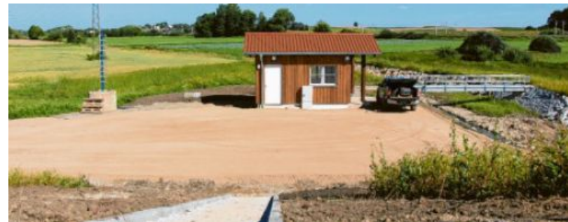
Neben dem Damm steht das neue Betriebsgebäude.
